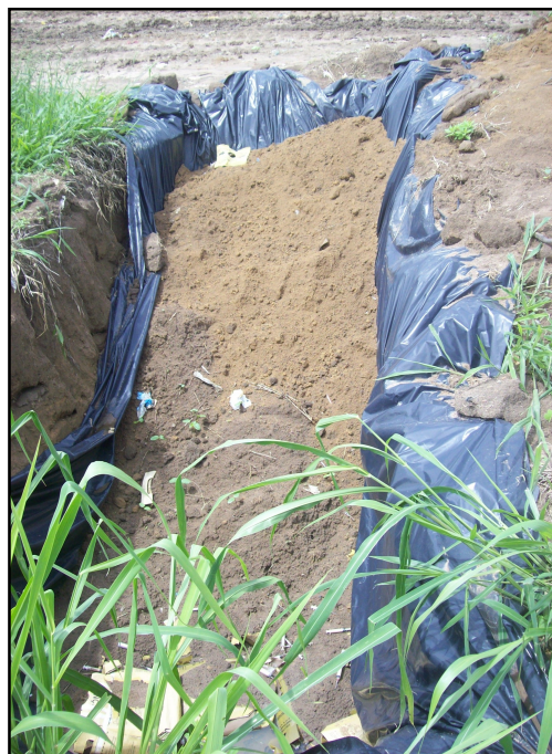
Figura 3.13: Vala séptica destinada aos resíduos hospitalares - Aterro Sanitário de Cruz das Almas/BA
