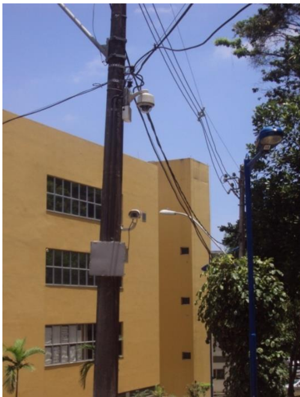
Figura 15: Câmeras no acesso ao Instituto de Geociências pela Av. Cardeal da Silva
