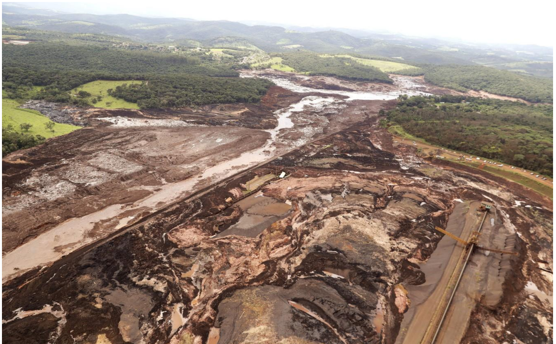
Figura 9 – Rompimento da barragem da Vale em Brumadinho-MG 19
