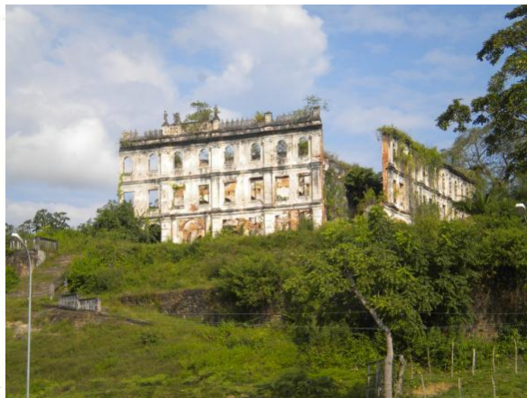
Figura 8: Escola Agrícola em São Bento das Lajes
