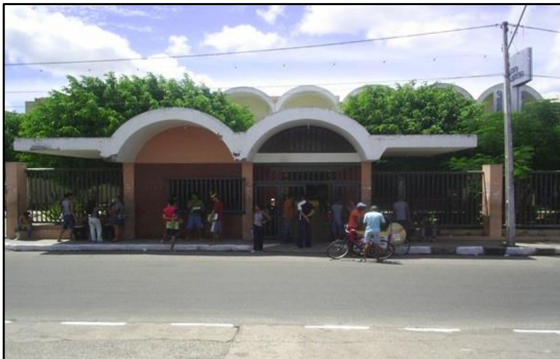
Figura 3.1 – Fachada da Unidade Escolar: C. M. Luís Eduardo Magalhães
