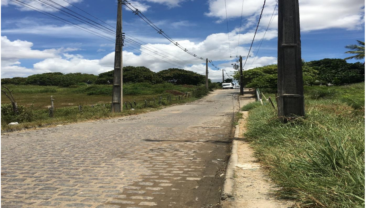
Figura 7 – Rua Itatiaia e o acesso a USF e Ponto de Ônibus Escolar
