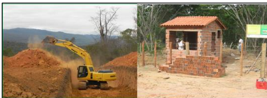
Figura 20 - Construção do aterro controlado do município de Andaraí - BA, 2010.
