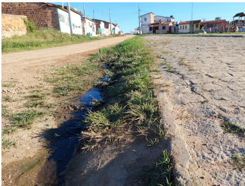
Figura 1 - Pode ser visto o calçamento da praça se encerrando antes que contemple moradores e com esgoto a céu aberto
