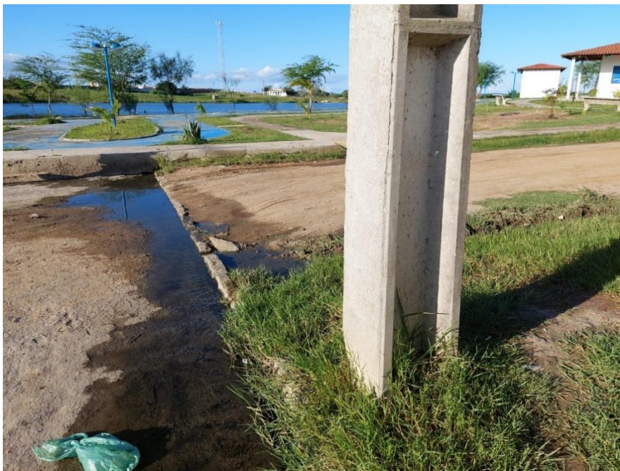
Figura 2 - É possível visualizar por outro ângulo a estrutura da praça em contraste com o espaço onde começam as moradias
