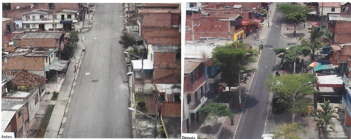
Figura 55 – Antes e depois da requalificação da rua no bairro Andalucía, na Colômbia.
