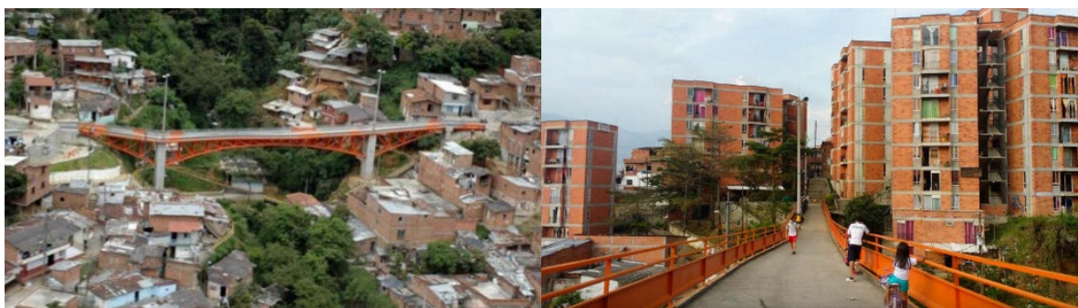
Figura 66 - Antes e depois do Projeto de Intervenção La Herrera, em Medellín.
