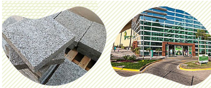
Figura 38 – Placa de pavimento de concreto poroso e estacionamento com pavimento intertravado de concreto no Shopping Barueri em São Paulo.
