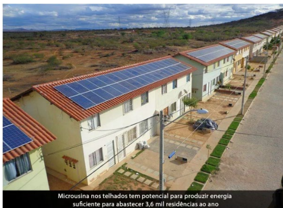
Figura 62 – Microusina de energia em condomínio popular baiano.
