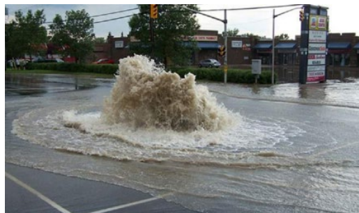
Figura 23 –. Extravasamento do sistema de drenagem em Ontário.
