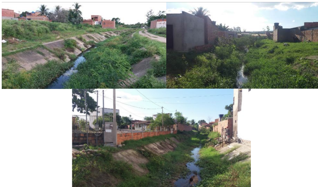
Figura 98 - Ocupações em áreas de risco no bairro Aviário.
