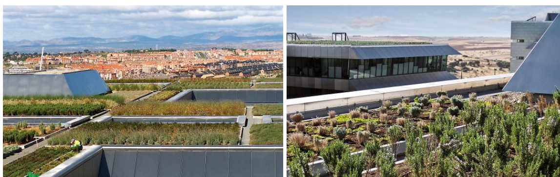
Figura 60 - Telhado verde do Banco Santander, em Madri, na Espanha.
