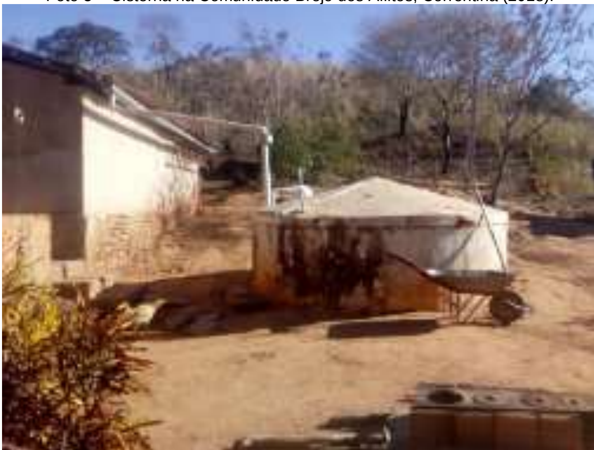
Foto 5 – Cisterna na Comunidade Brejo dos Aflitos, Correntina (2018).
