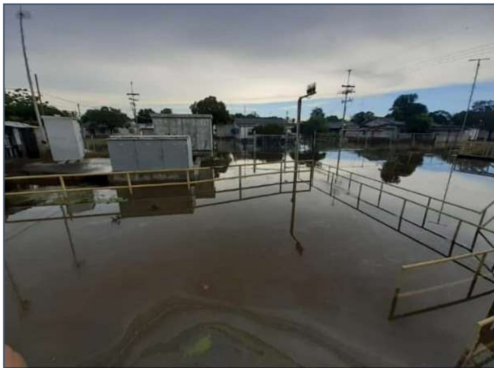
Figura 59: Estação de bombeamento inundada em campo Alegría, Lagunillas (2021).
