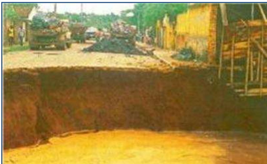
Figura 18: Registro da subsidência ocorrida em Sete Lagoas (1988).
