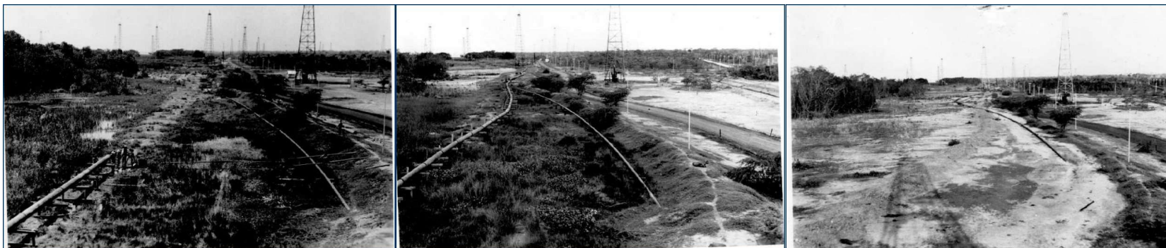
Figura 41: Fotografias tiradas do poço LS_137, em direção ao norte. Data: março (esq.) e junho (centro) de 1941 e fevereiro (dir) de 1942.
