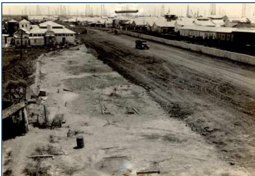
Figura 48: Início do enchimento para a construção de um dique costeiro de maior tamanho, frente a Lagunillas.
