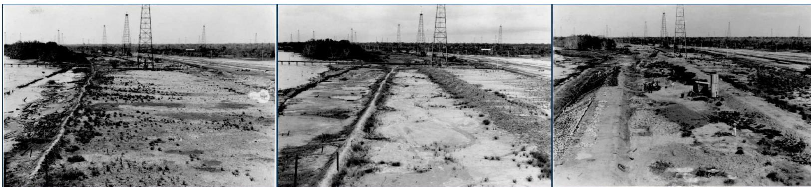
Figura 42: Fotografias tiradas do poço LS_89, em direção ao norte. Data: março (esq.) e junho (centro) de 1941 e fevereiro (dir) de 1942.
