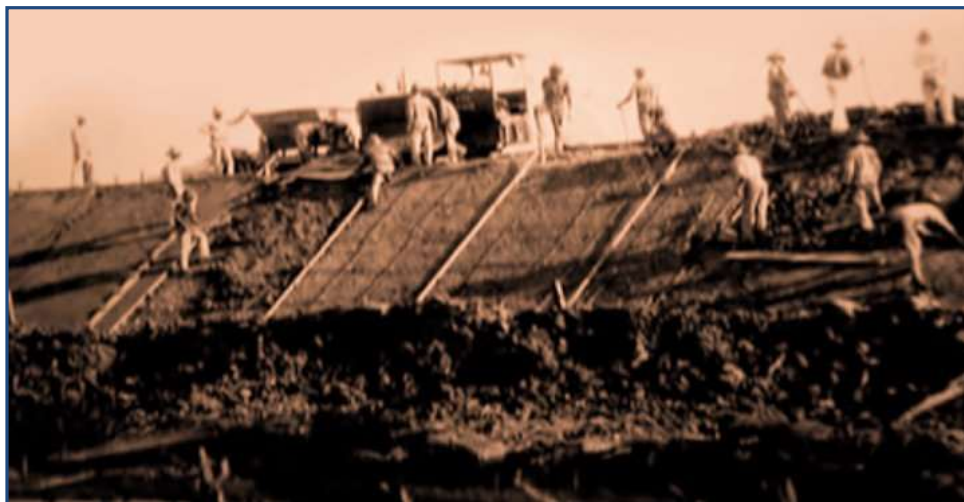
Figura 51: Construção do novo dique, em frente a Lagunillas.
