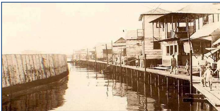
Figura 45: Dique construído entre o limite das concessões da LPC e o povoado de Lagunillas de Agua.
