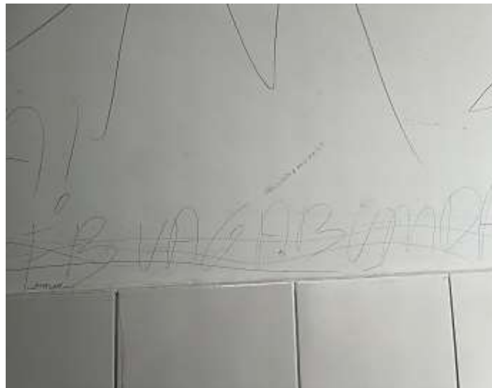
Registro fotográfico 2 - Parede da sala de aula do 9º ano.
