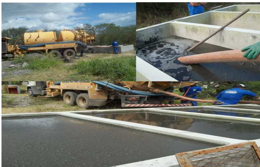
Figura 3: Descarga do lodo de esgoto da ETE- Contorno nos leitos de secagem localizados na EEA/UEFS.
