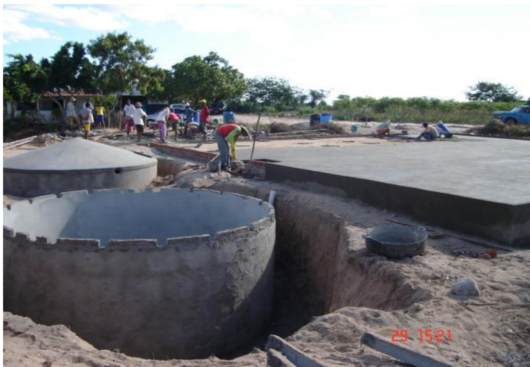
Imagem 12 – Construção da cisterna produção – Projeto Piloto.
