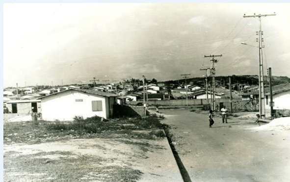
Conjunto Habitacional : Camaçari - [19--]
