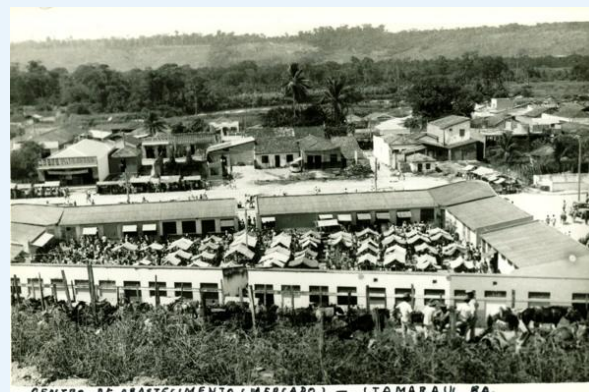
Centro de abastecimento
