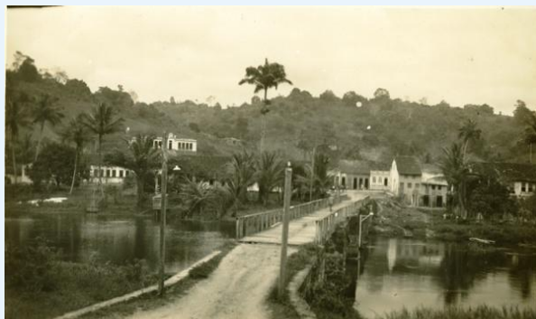
Ponte sobre o Rio Jiquiriçá: Laje, BA – 1949
