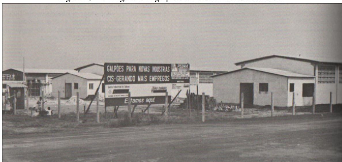
Figura 29 – Fotografia de galpões do Centro Industrial Subaé
