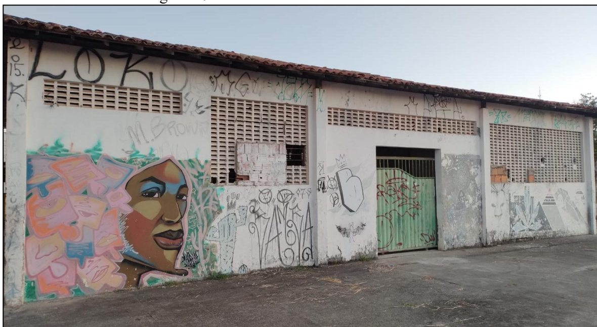
Figura 102 - Estrutura de armazém abandonado
