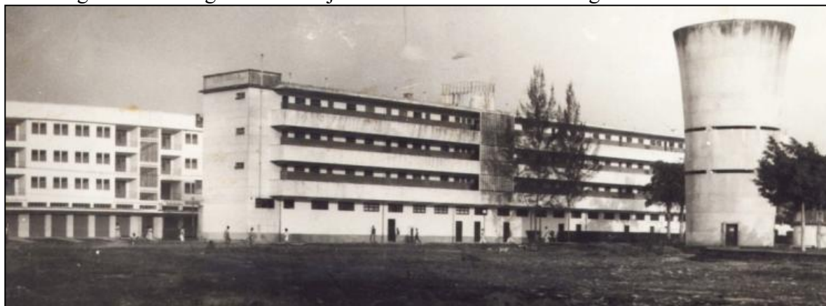
Figura 10 - Fotografia do Conjunto Habitacional de Realengo no Rio de Janeiro
