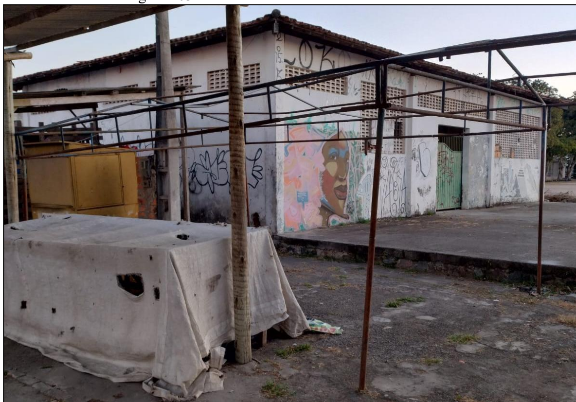
Figura 103 - Estrutura e barraca de feira abandonada
