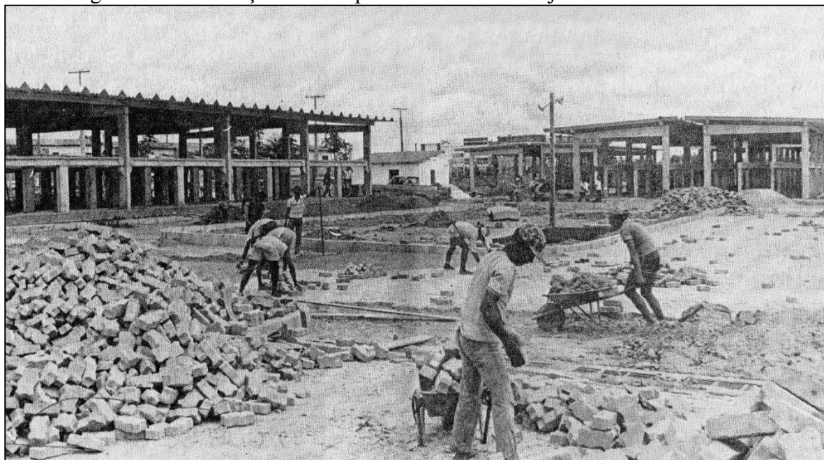
Figura 37 - Construção do Complexo Policial no Conjunto Feira III em 1983
