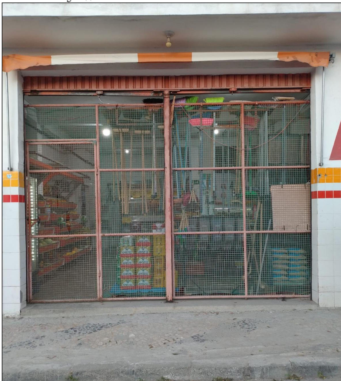
Figura 99 - Grade em uma das entradas de um mercado local
