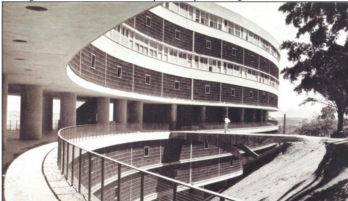
Figura 7 - Fachada do Bloco Principal do Conjunto Pedregulho no Rio de Janeiro
