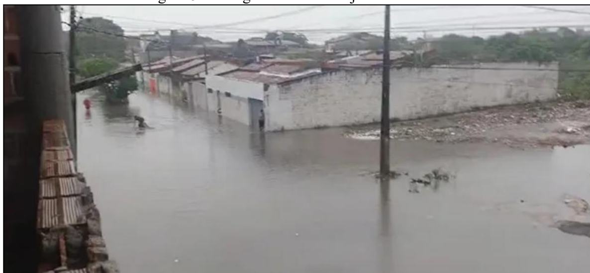
Figura 51 - Alagamento em Conjunto Feira VII
