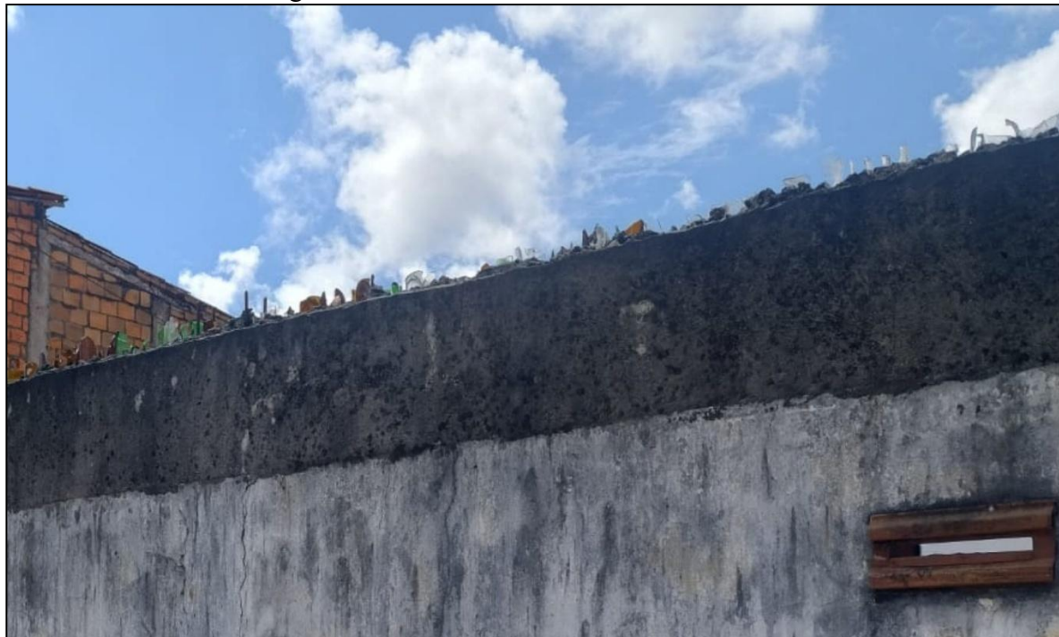
Figura 98 - Muro munido com cacos de vidros
