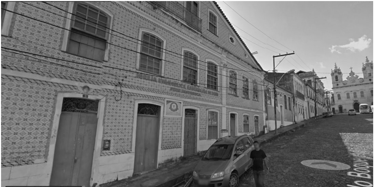
Figura 1- Imagem do templo da Assembléia de Deus do Boqueirão, à esquerda, no canto superior direito, a Igreja de Nossa Senhora da Conceição do Boqueirão. 110
