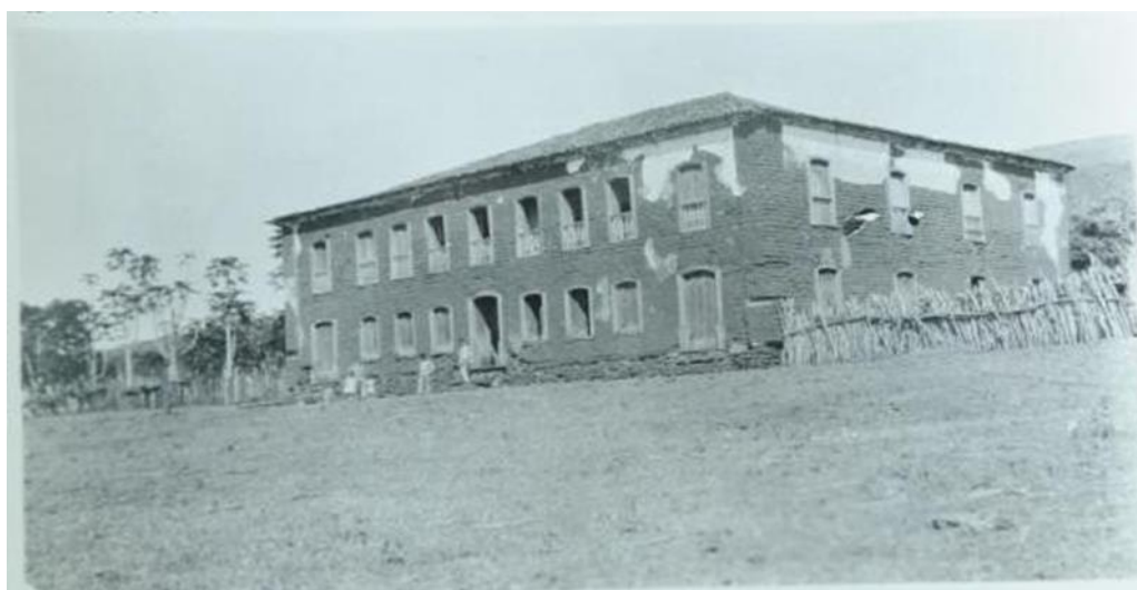
Figura 18: Sobrado da Fazenda do Brejo do Campo Seco.
