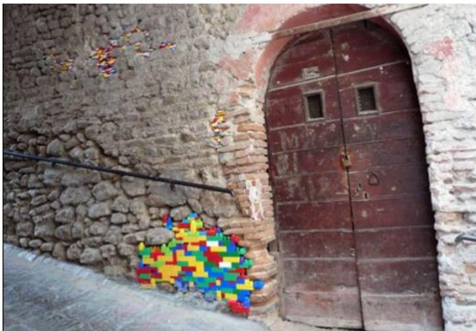
Figura 59: Restauração de muro com peças de LEGO. Jan Vormann, Bocchignano-Itália
