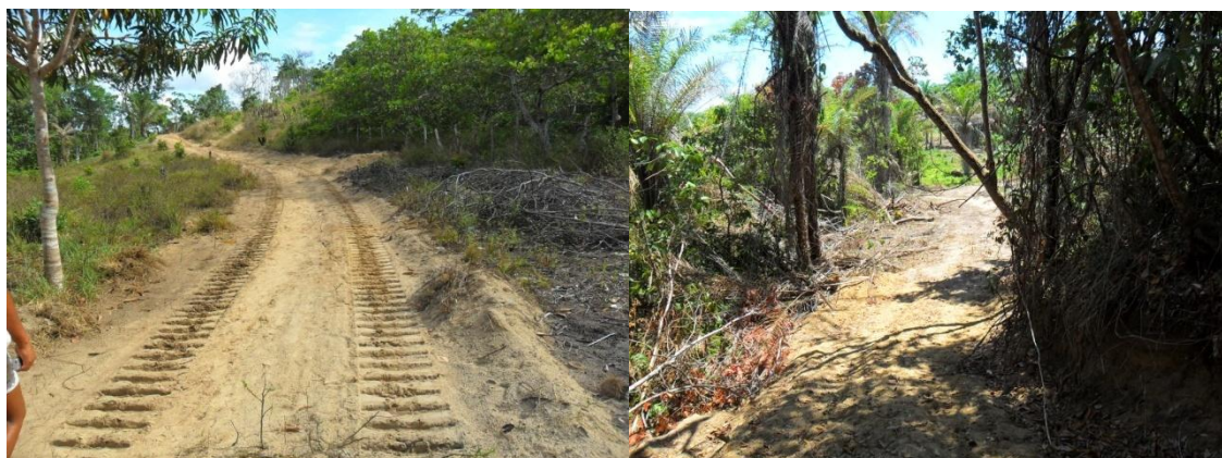
FIGURA 49 – Abertura de estradas em Salamina Putumuju. FONTE: A autora (2013).
