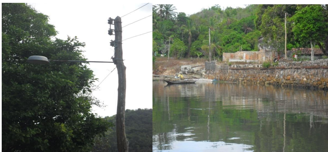
FIGURA 50 – Rede de energia elétrica utilizada na Antiga casa Sede da Fazenda de Salamina. FONTE: A autora (2013).
