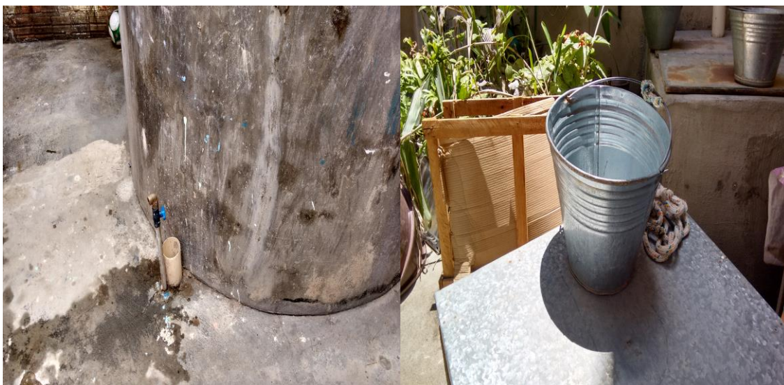
Figura 14 - Formas de retirar água da cisterna: 1) Torneira e 2) Balde
