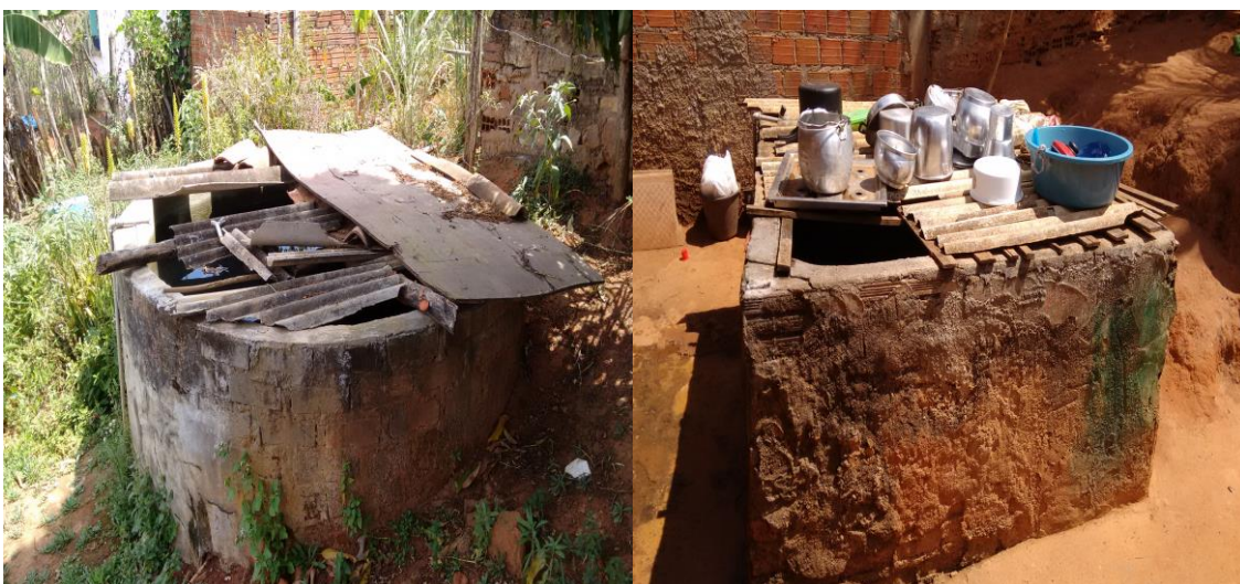
Figura 12 - Vista geral das tampas dos reservatórios de armazenamento de água na cidade de Baixá Grande
