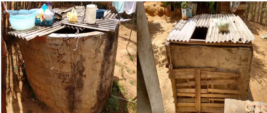
Figura 11 - Vista geral das tampas dos reservatórios de armazenamento de água em Baixá Grande
