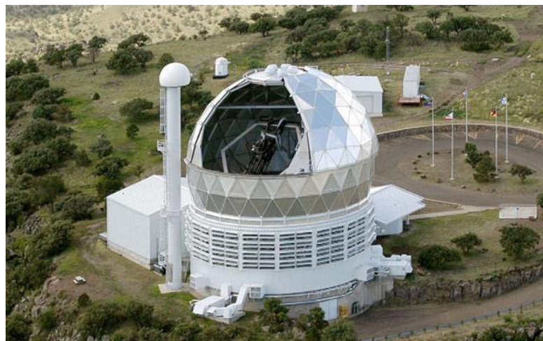
Figura 10 - Southern African Large Telescope – SALT. A torre frontal representa o sistema de alinhamento.
