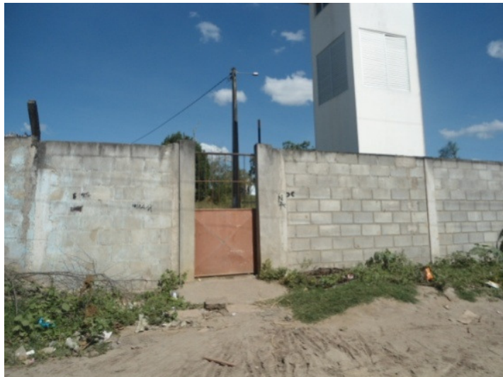
Figura (4.31) Muro da UEFS. Vista externa do Bairro Campo Limpo (Comunidade Páu de Léguas)
