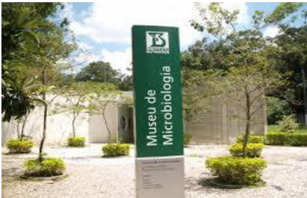
Figura 1. Fachada do Museu de Microbiologia
