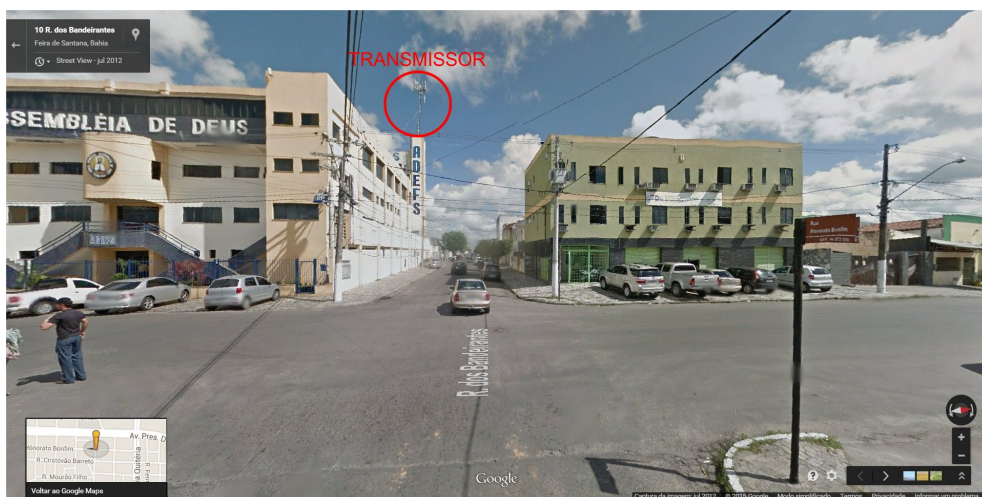
Figura 3.10: Foto da ERB na Rua dos Bandeirantes [Google Earth].
