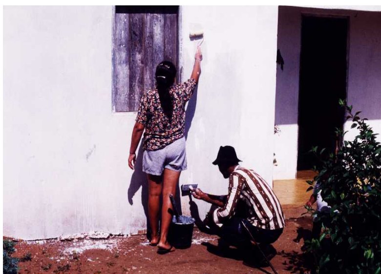
Figura 3 – Moradores da zona rural do município de Valente pintando a casa com a “baba” da palma ( Opuntia ficus-indica ) associada à cal
