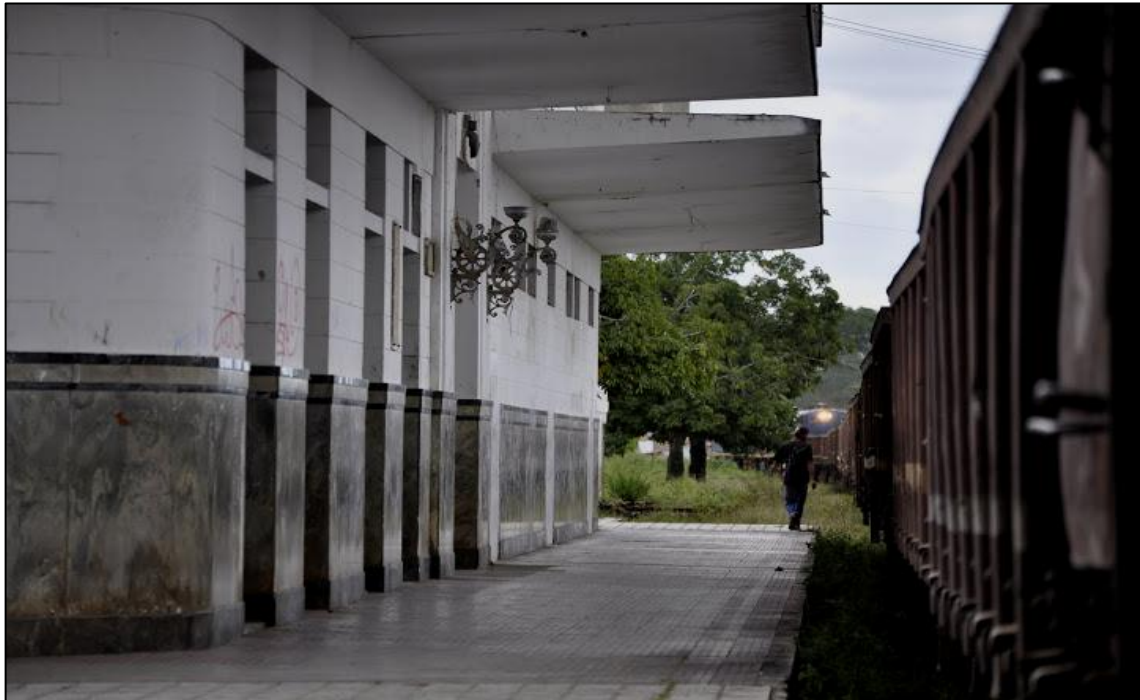
Figura 44 – Estação Ferroviária – Serrinha – Bahia - 2013
