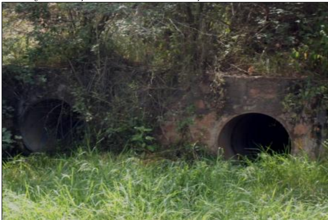
Figuras 65 – Lançamento de efluentes domésticos no açude do Gravatá – Serrinha - Bahia
