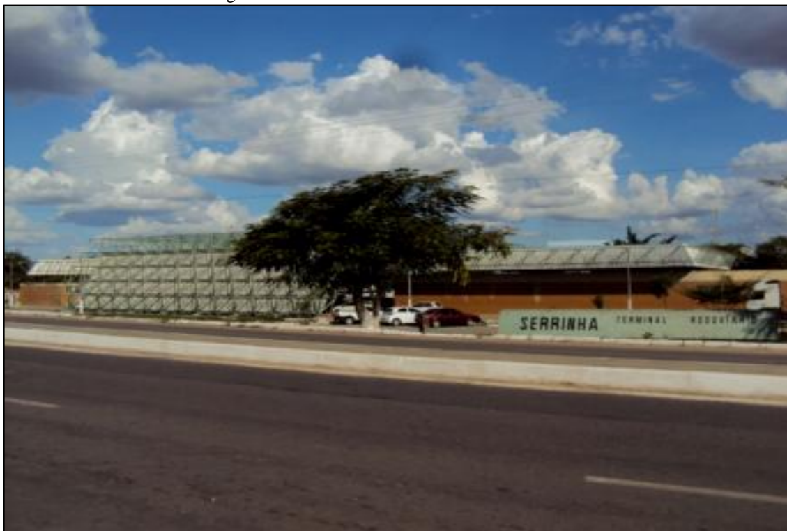
Figura 54 – Terminal Rodoviário Serrinha - Bahia
