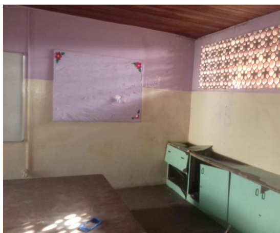
Foto: Sala antes da reforma
