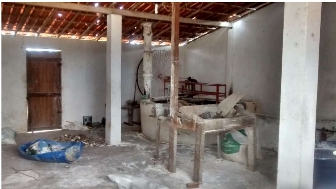
Figura 18 – Imagem da área interna da casa de farinha
