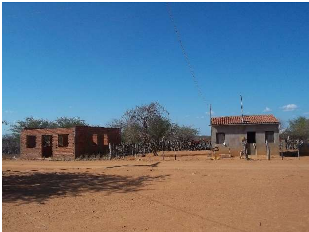
Figura 06 – Residências na Lagoa do Rancho
