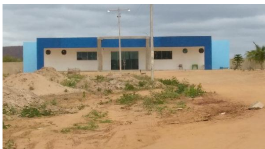
Extensão da Escola Estadual Luzia de Freitas
