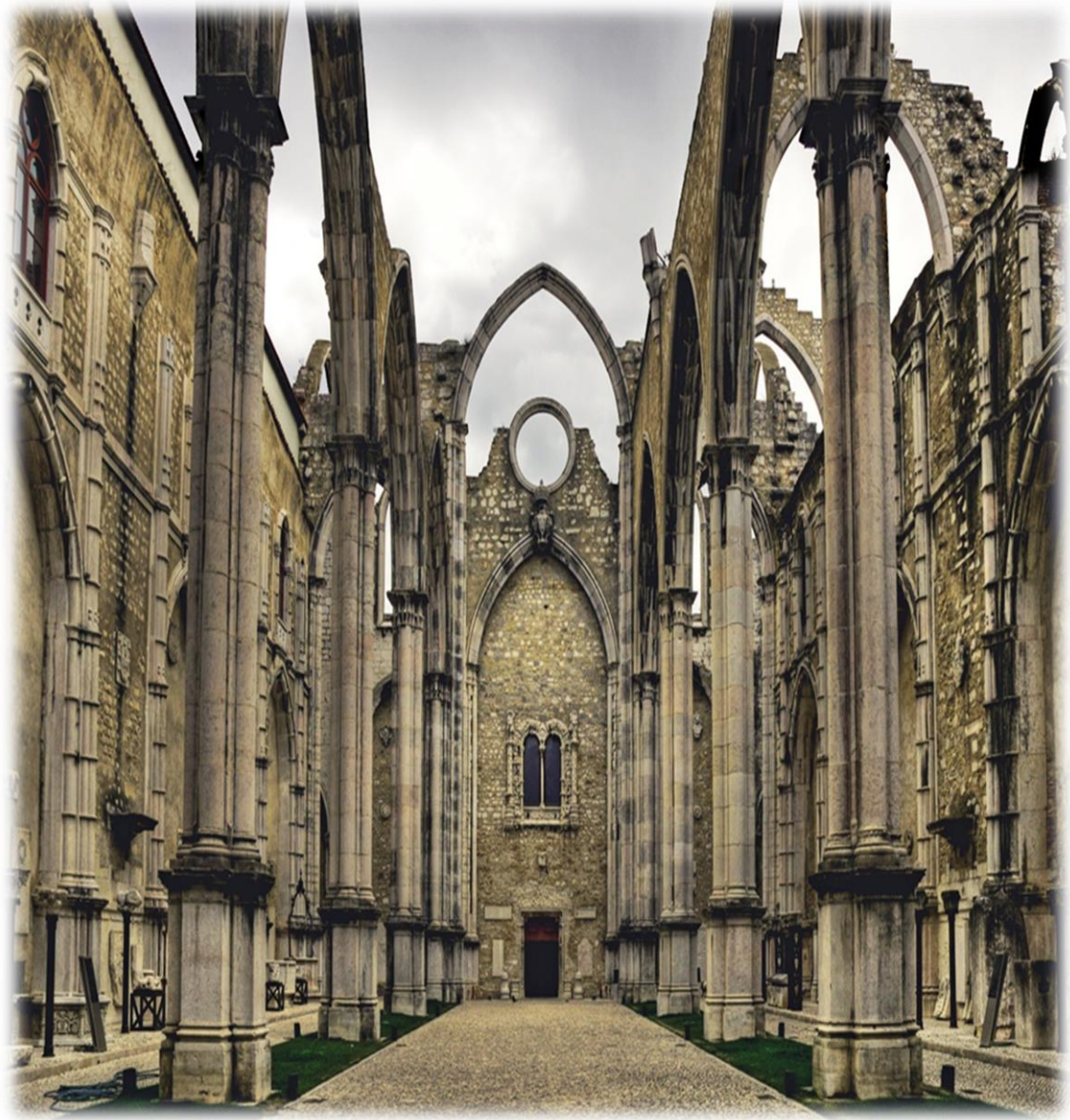
RUÍNAS DO CONVENTO DO CARMO, LISBOA Vestígios do grande terremoto de 1 de novembro de 1755
