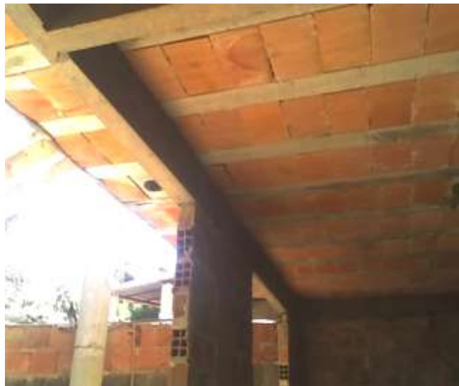
Figura 2.1 Laje nervurada pré-moldada em construção – fotografia de vista inferior Fonte: O Autor (2018)
