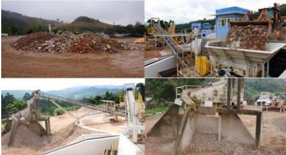
Figura 4.4 Usina de reciclagem de entulho (tipo fixa) da cidade de Guarulhos. Fonte: FRASSON, 2017
