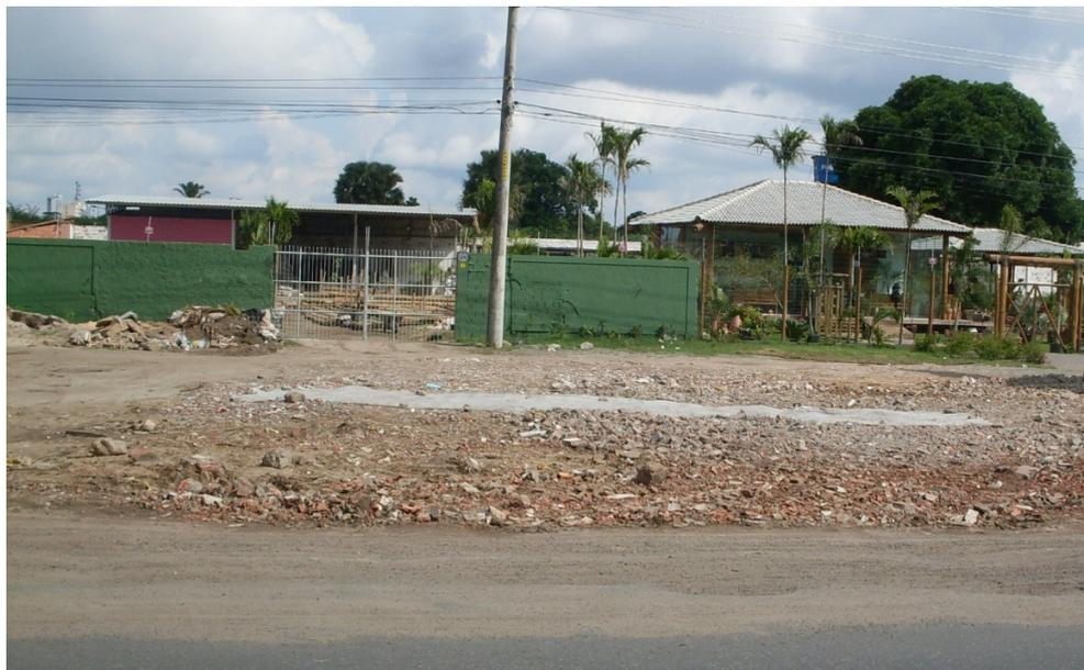
Figura 2 Utilização do RCD em regularização de terreno
