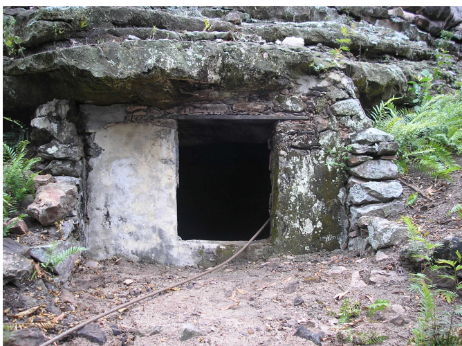
Figura 16: Cacimba de água protegida por casinha. Foto: Russ, 2010.
