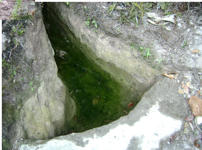
Figura 17: Cacimba de água com contenção de cimento. Foto: Russ, 2010.
